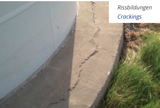
Schollenartige Abplatzungen am Beton Clod-like spalling of the concrete
